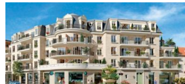
Illustration 34. Exemple de programme en cours sur l'avenue de la Division Leclerc, source : Franco Suisse
