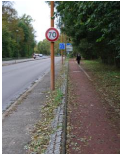
Illustration 77. Piste cyclable le long de la RD 986 en direction de l'A 86 à Châtenay-Malabry, source : Groupement SARA
